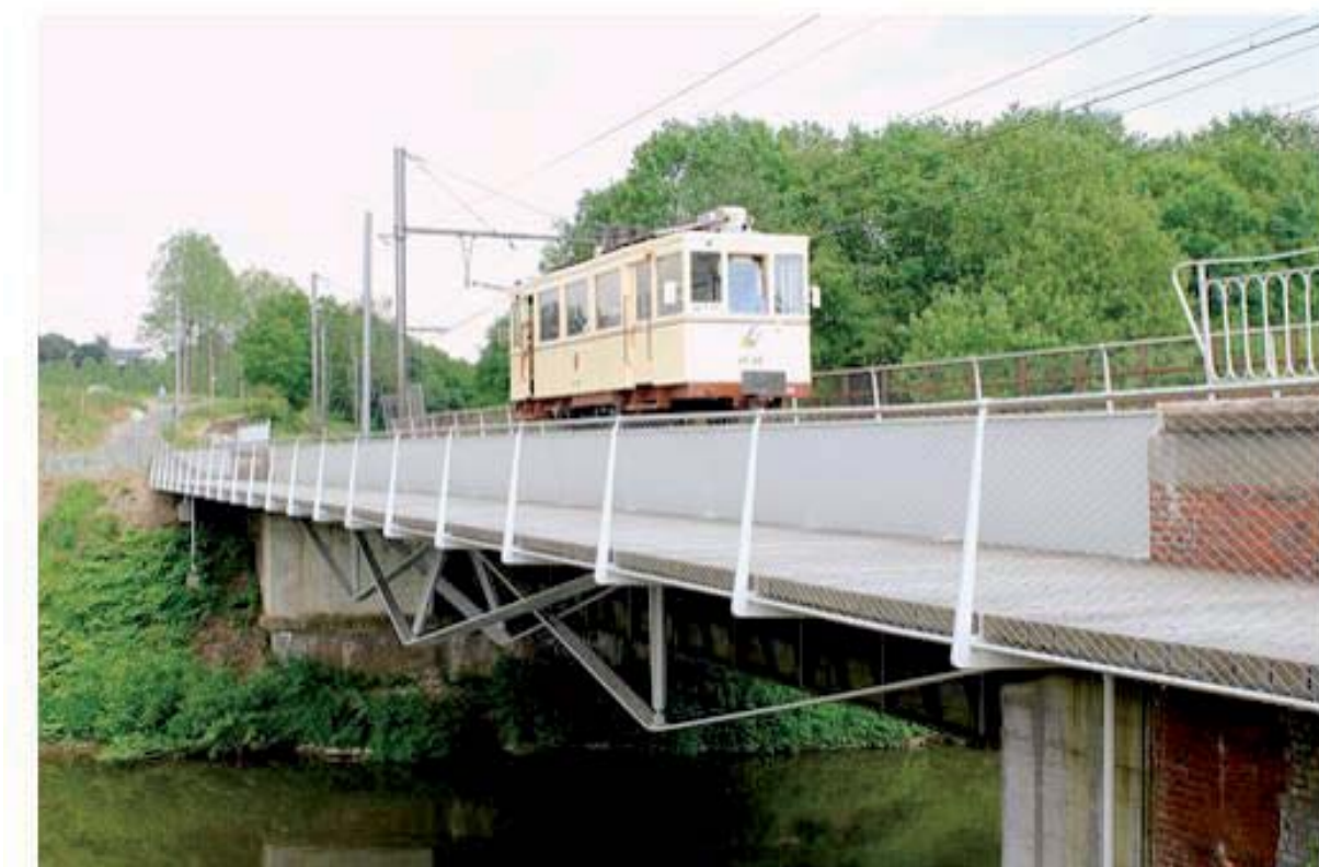
Figure 17 : intégration d'un RAVeL le long d'un pont sur la Sambre à Thuin (MSA)
