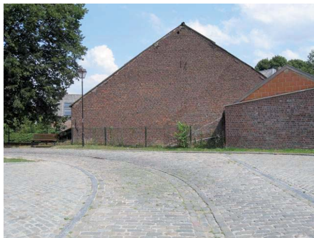
Figure 7 : pignon donnant sur l'arrière de l'Eglise où pourrait être aménagé l'accès aux étages (JNC AWP)
