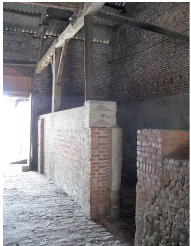
Figure 15 : murs porteurs de la charpente
