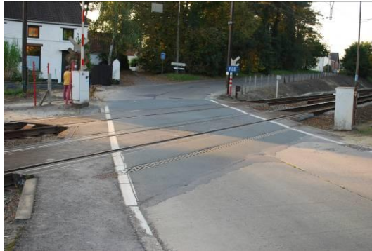
Figure 7 : Passage à niveau à hauteur du point d'arrêts SNCB d'Archennes (JNC AWP)
